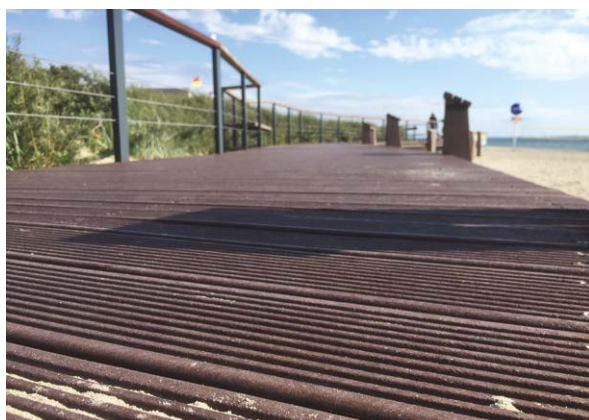
Esempio di materiale utilizzato per la costruzione di un pontile con perline pavimento con misure 4 x 17.
