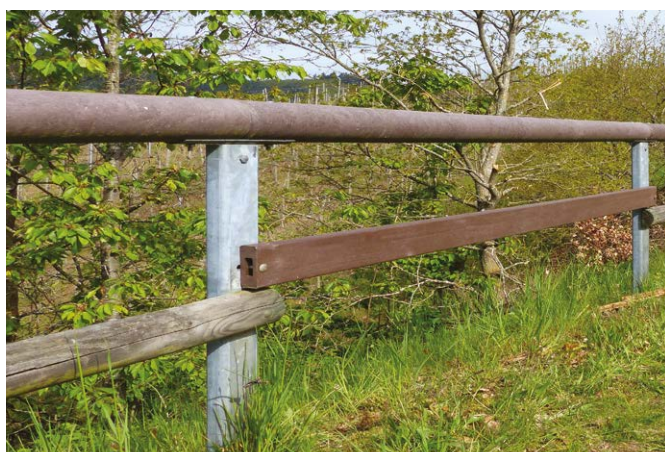
Palo orizzontale rinforzato con anima in acciaio zincato S235, ø 42,4 mm circa, spessore 2,5 mm circa.
